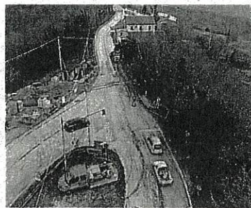
I lavori sulla Strada provinciale 11
