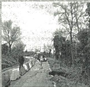
Il cantiere sulla Sp 9
