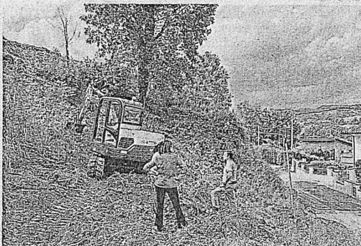
Lavori in corso a Bivio Montegelli
