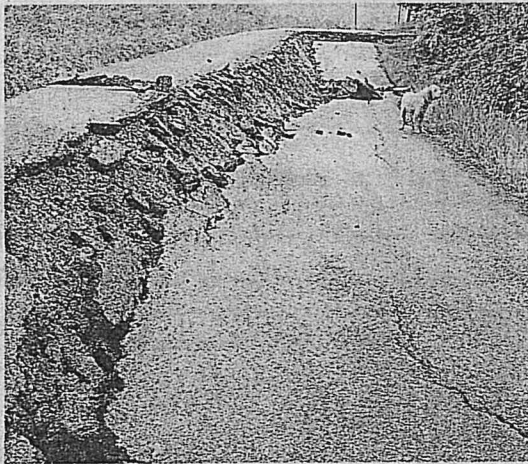
La strada sconquassata dalla frana a Montecodruzzo
