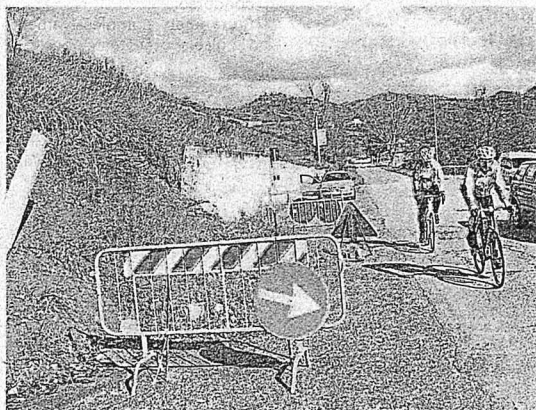
La frana arrivata sulla strada Provinciale Uso alle porte di Ponte Uso, frazione di Sogliano al Rubicone
